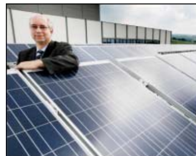
Sonne hilft bei Phoenix sparen ■ Hünneberg Opti. Über die 14000 m² große Photovoltaikanlage der Hünneberg Opti, die im März 2008 in Betrieb genommen wurde, können nun regenerative Energien wie das Sonnenlicht genutzt werden. Die Anlage ist mit 1000 kW Leistung ausgestattet und wird durch ein intelligentes Tracking-System optimiert. Die Anlage ist Teil eines Power-Heat-Cold-Systems, das die Energieeffizienz des Gebäudes erhöht. Durch die Nutzung erneuerbarer Energien wird der CO 2 -Ausstoß reduziert. Die Anlage ist ein Beispiel für die erfolgreiche Integration erneuerbarer Energien in die industrielle Produktion. Die Anlage ist ein wichtiger Bestandteil der Hünneberg Opti's nachhaltigen Energiekonzepts. Die Anlage ist ein Beispiel für die erfolgreiche Integration erneuerbarer Energien in die industrielle Produktion. Die Anlage ist ein wichtiger Bestandteil der Hünneberg Opti's nachhaltigen Energiekonzepts.
